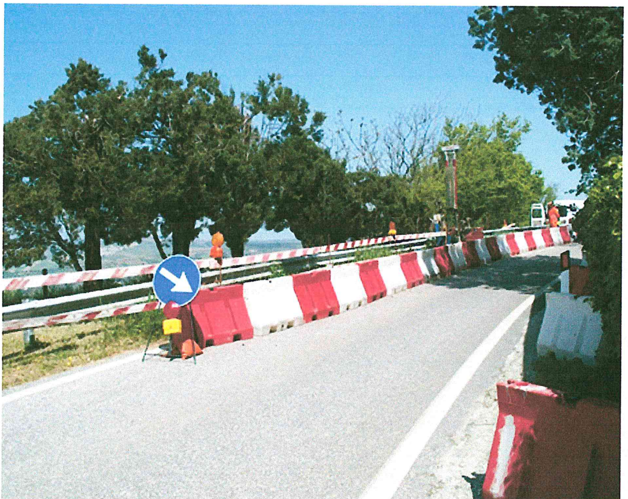
Tratto di strada transennato visto dal lato Riolo con DPSH.2 in esecuzione
